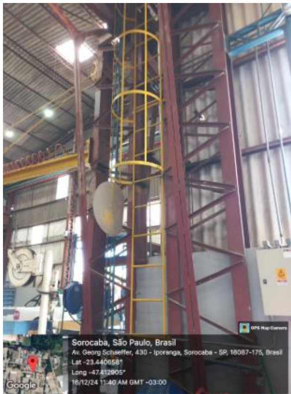
Escada vertical com guarda corpo tipo marinho acesso ao telhado da produção, aproximadamente 20m com plataforma Acesso a ponte central
