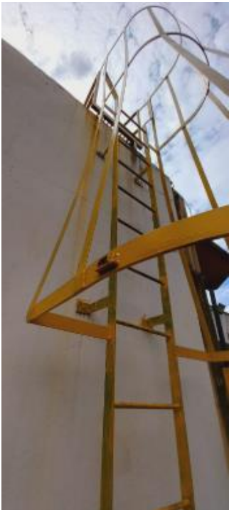
Escada vertical com guarda corpo tipo marinho acesso ao telhado do prédio ADM, aproximadamente 3m
