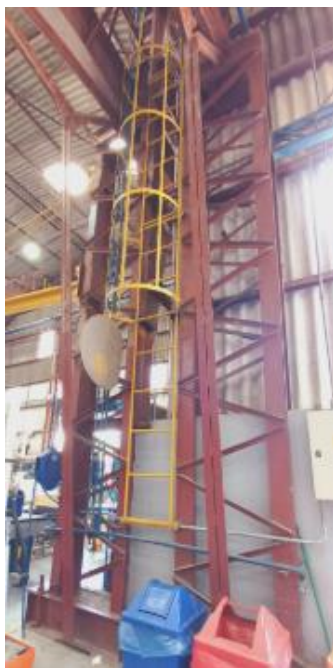
Escada vertical com guarda corpo tipo marinheiro acesso ao telhado da produção, aproximadamente 20m com plataforma Acesso a ponte rolante central
