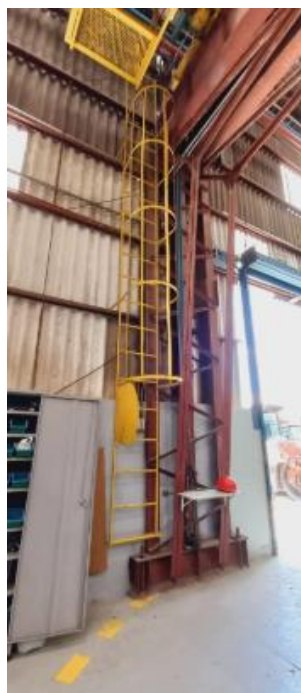
Escada vertical com guarda corpo tipo marinheiro acesso ao telhado da produção, aproximadamente 20m com plataforma Acesso a ponte lateral direita da produção.
